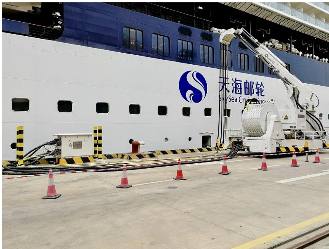
图2.6-1 蛇口邮轮码头完成首次连船供电
